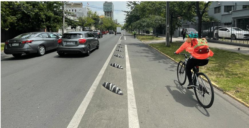
**Fotografía 5.** Segregación. Ciclovia Unidireccional al costado derecho en vía de un sentido. Fotografía: Tomás Echiburú Altamirano.
